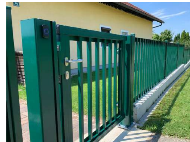
Osební prehod Aluminijaste navpične palice 32 mm, barva zelena
