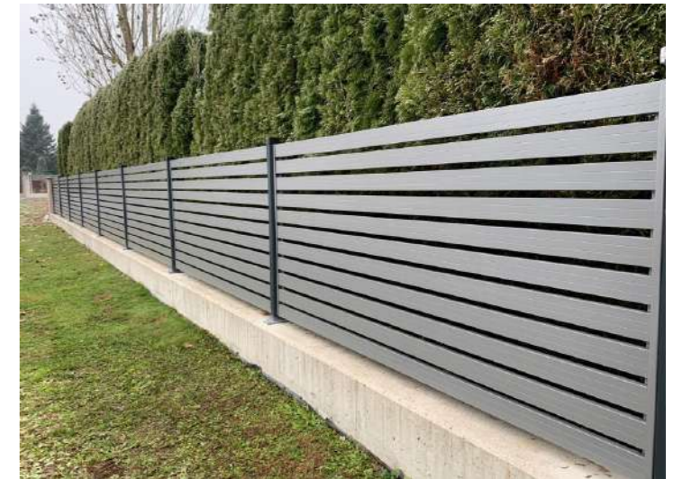
Aluminijasta ograja Aluminijaste prečne letve 65 mm, srebrna barva in antracit
